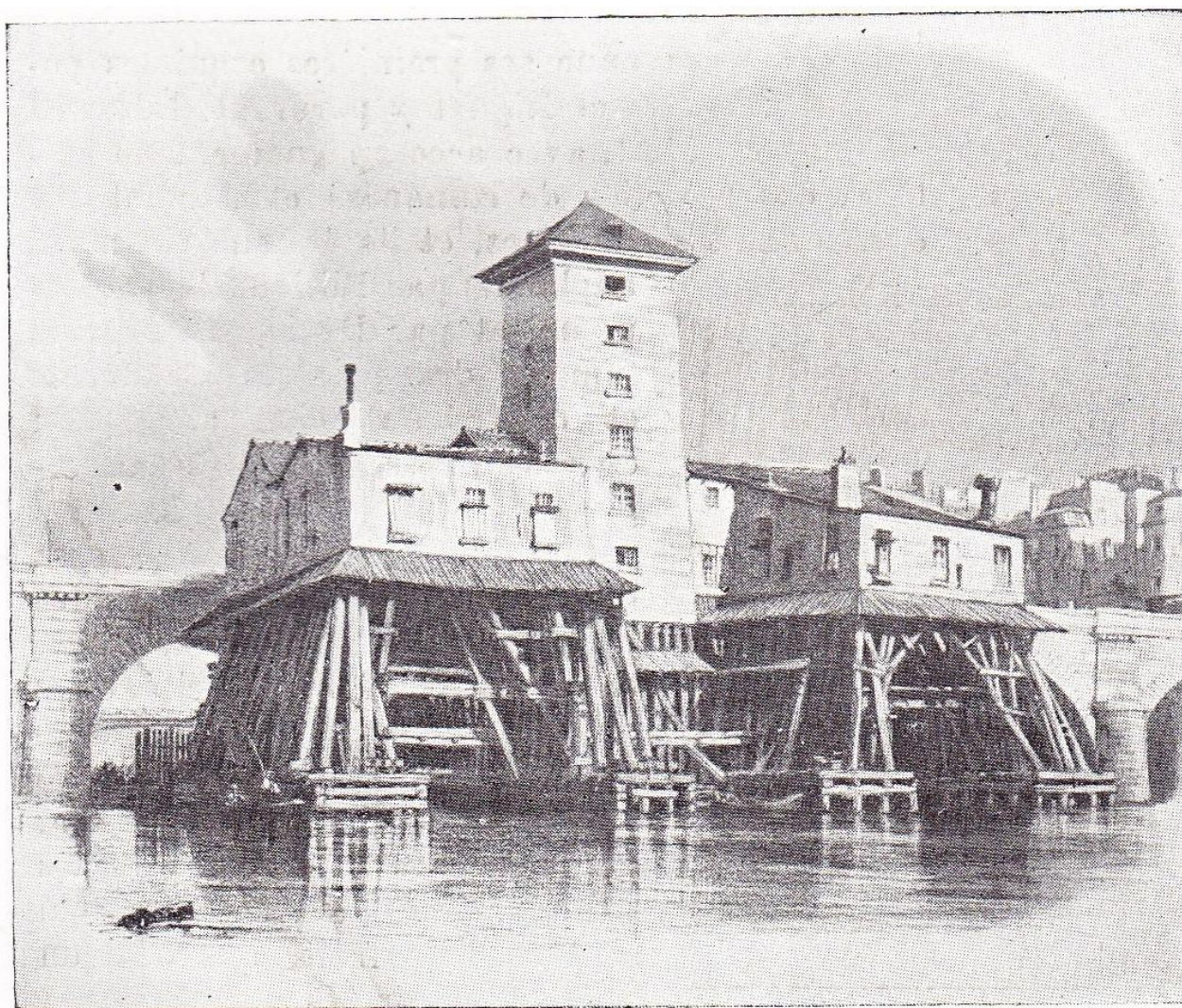
LA POMPE A FEU DU PONT NOTRE-DAME.
